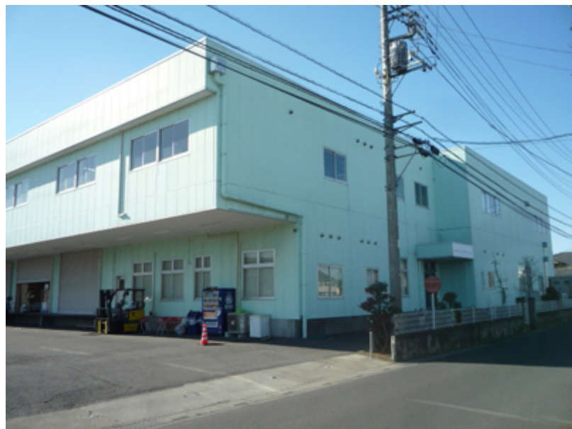
埼玉サービスセンター外観
